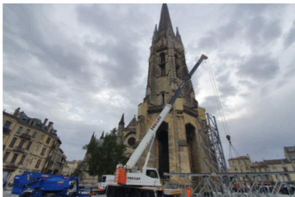
L'installation de la charpente métallique et des échafaudages avait duré de fin 2022 à mi-2023. (©Actu.fr / Nicolas Gosselin)
